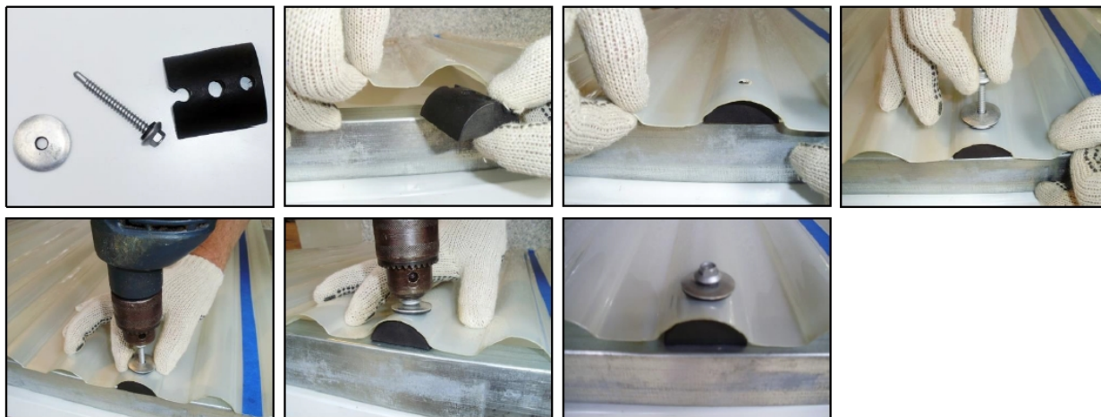
Figura 19. Detalhe do parafusamento das telhas em policarbonato.
