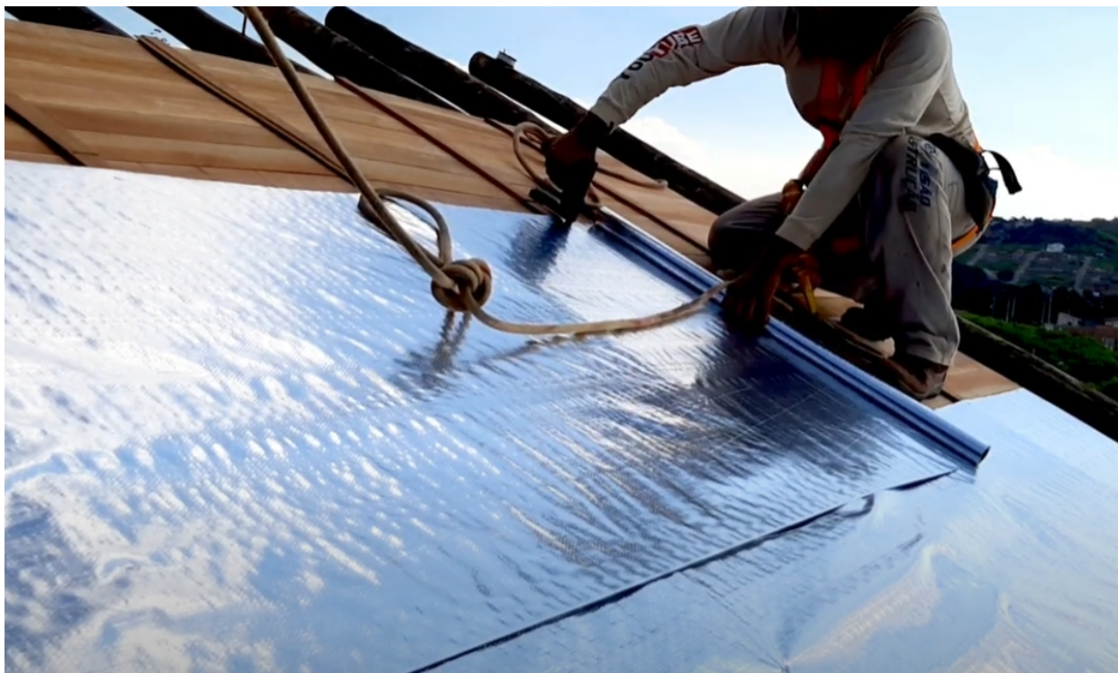
Figura 16. Fixação da manta de subcobertura.
