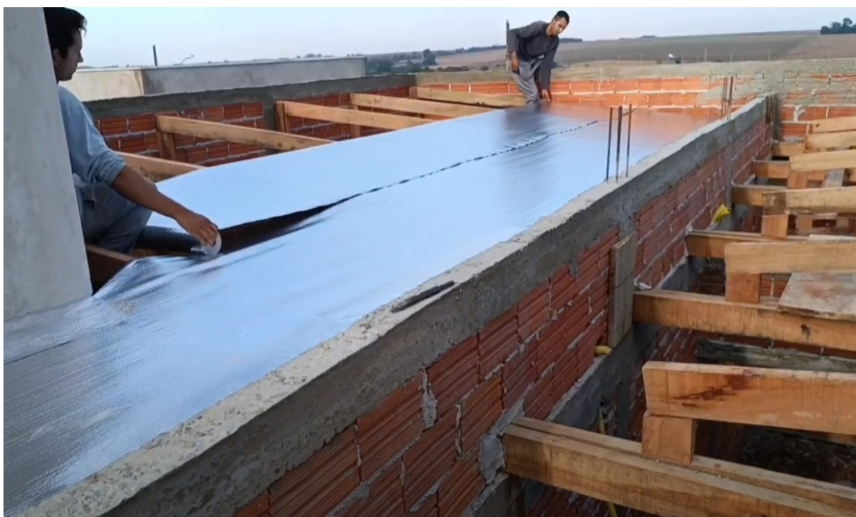
Figura 5. Instalação de manta de subcobertura
